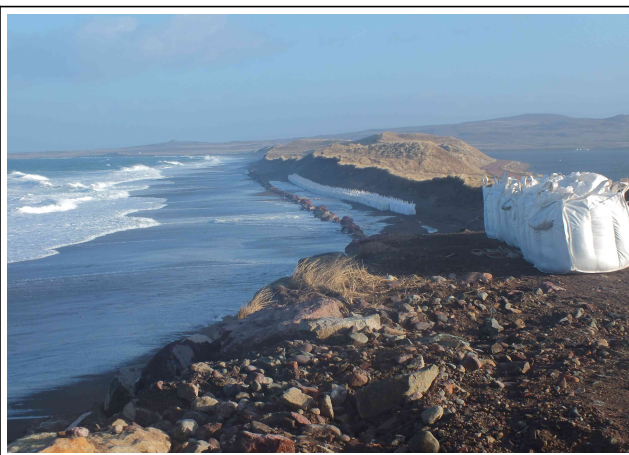
173 m de Cordon de big-bags en place
